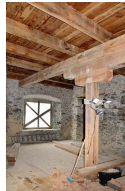
II. 6 Wnętrze izby na drugim piętrze budynku zamkowego po pracach przy odbudowie stropów, Płonina 2020
