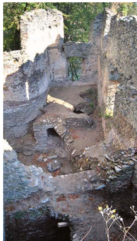
II. 7 Wnętrze skrzydła zamku podczas prac przy odgruzowaniu, Płonina 2011
