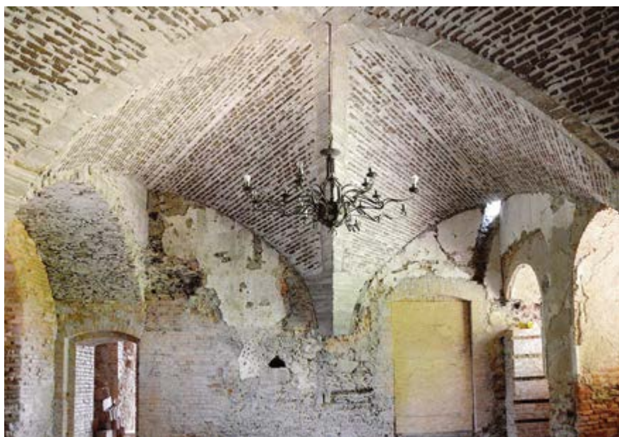
Il. 10 Wielka sala dworu po odbudowie konstrukcji sklepienia, Płonina 2021
