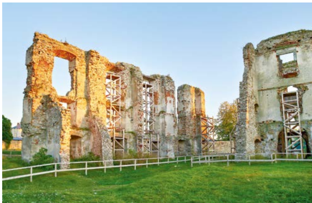
Il. 2 Bodzentyn – tymczasowo zabezpieczone mury Fot. Shutterstock
