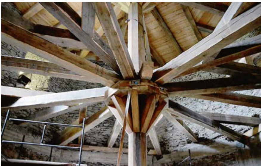
II. 5 Wnętrze wieży po założeniu stropów, widok na kondygnację 4 i 5, Płonina 2018
