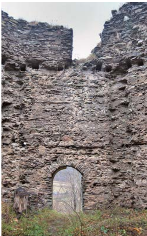
II. 3 Wnętrze wieży w zamku Niesztyno przed odgruzowaniem niższych kondygnacji, 2011
