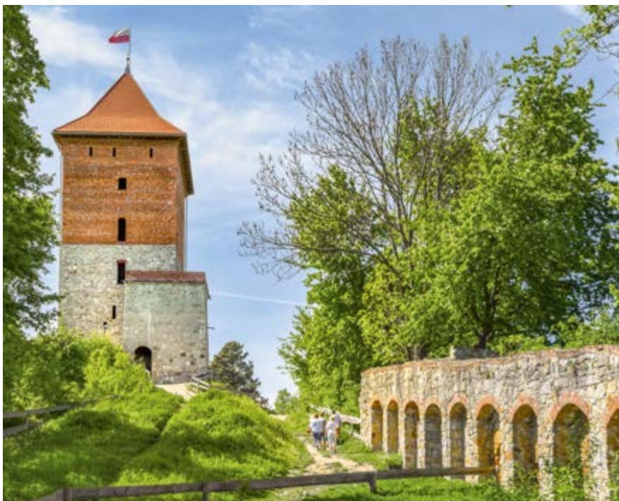
II. 7 Zamek w Melsztynie. Częściowa rekonstrukcja wieży mieszkalnej Fot. Henryk Sadura /Shutterstock
