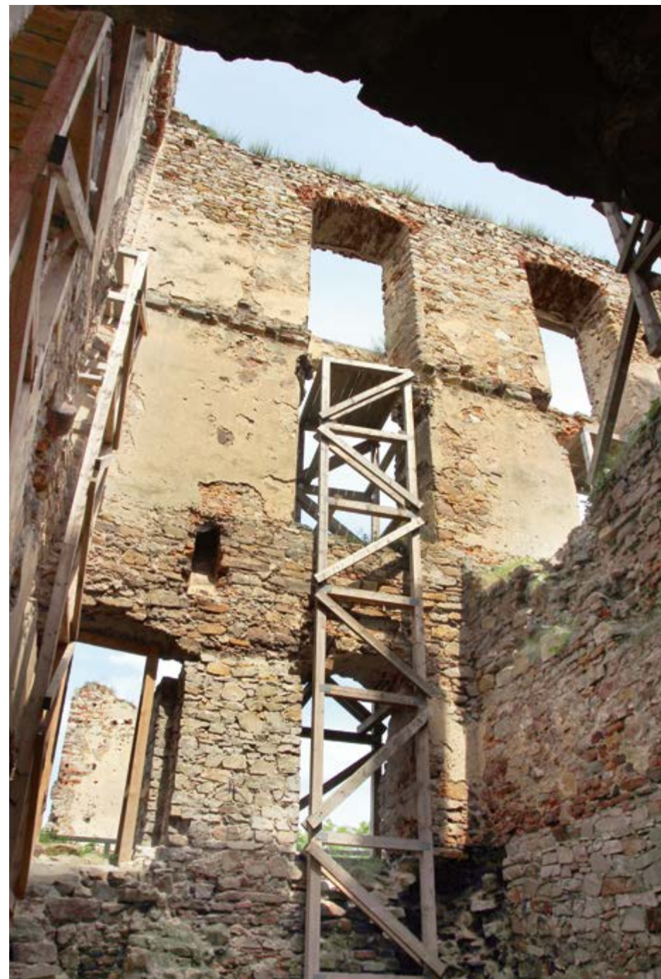
Il. 3 Bodzentyn – tymczasowo zabezpieczone mury Fot. Shutterstock
