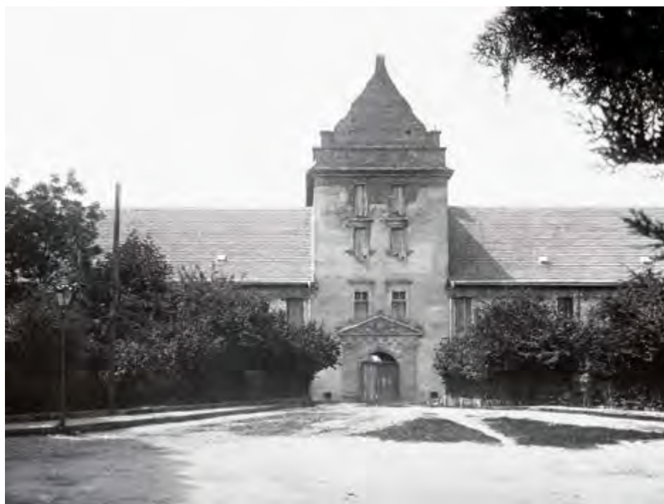
II. 7 Zamek w Żółkwi po odbudowie dachów, 1922 Fot. NAC
