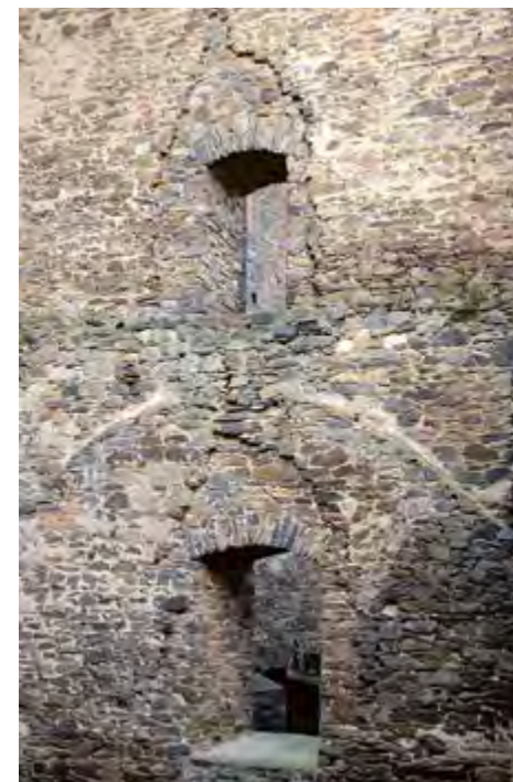
II. 8 Zamek Krakovec, cofnięty dobudowany mur z okresu konserwacji analitycznej, zdjęcie 2008 Fot. Jiří Varhaník
