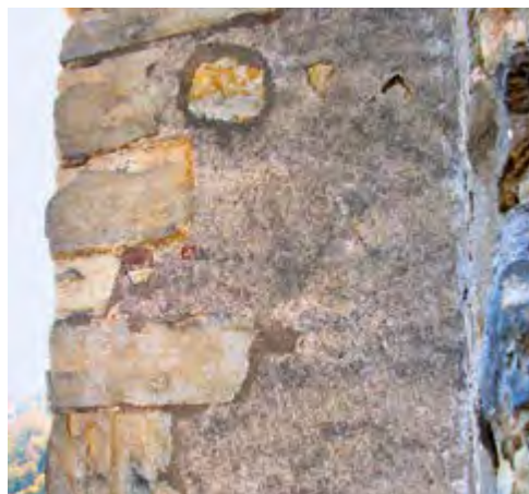
II. 22 Zamek Boskovice, przykład prac konserwatorskich z lat 30. i 40. XX w. Konserwacja krawędzi zabytkowego tynku przy wzmocnionym narożniku, 2010
