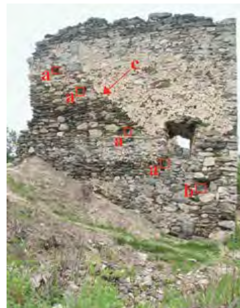
II. 8 Zamek Brničko, boczna fasada pałacu, 2013
