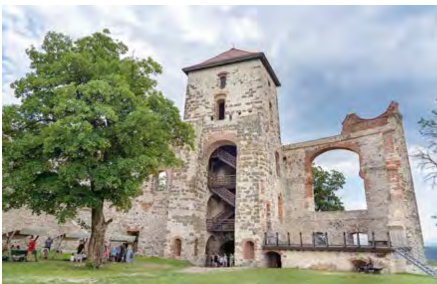
II. 6 Wieża Bramna i fragment skrzydła południowo-wschodniego po konserwacji, zamek Tenczyn. Filar z prawej strony połączony łukiem ceglany z murem przy wieży przez Zygmunta Hendla, 2023 Fot. Jan Janczykowski
