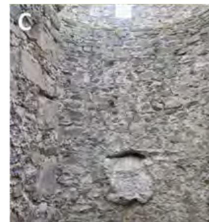
II. 28 Zamek Helfštýn, widok na wnętrze baszty ze spoinowaniem cementowym
