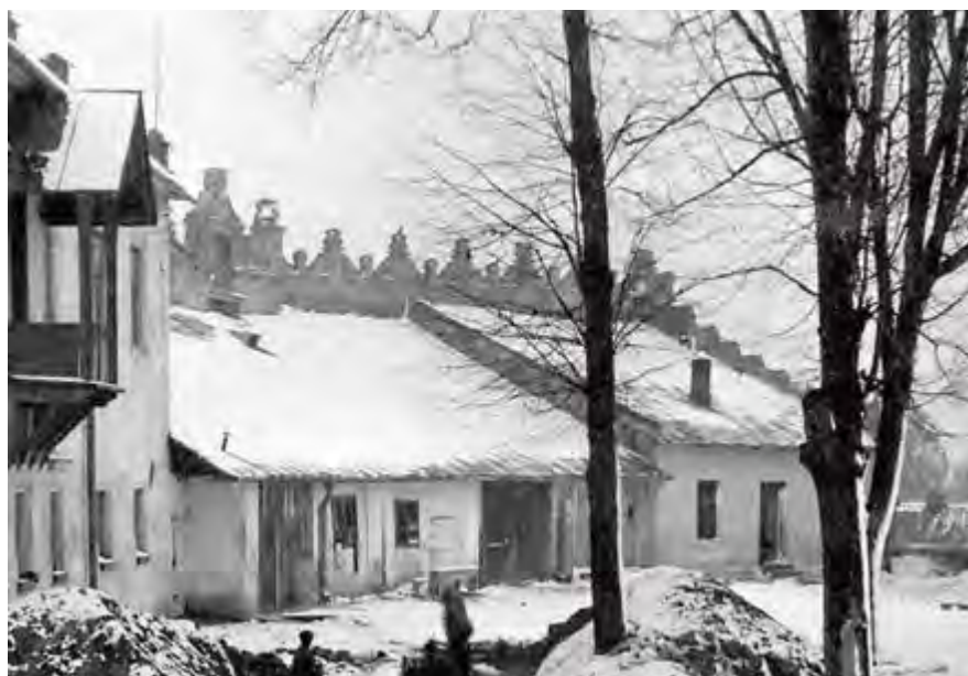
Il. 19 Zamek w Nowym Sączu, przed restauracją i rozbiórką chałup przylegających do murów, lata 20. XX w. Fot. Domena Publiczna
