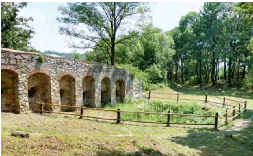
Il. 20 Mur centralnej części zamku w Melsztynie od strony północnej, przed kilku laty wyremontowany przez gminę Zakliczyn. Ogrózione miejsce wyznacza zapadlisko po zawaleniu się sklepienia piwnicy czy cysterny. Miejsce nigdy niebadane, 2016
