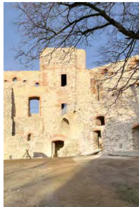
II. 7 Widok na północno-wschodni narożnik dziedzińca po pracach konserwatorskich, zamek Tenczyn. W głębi baszta Dorotka. Fragment zawalonego sklepienia nad parterem obok Dorotki odbudowano w pierwotnej formie w celu zapewnienia dostępu do wnętrza baszty na poziomie piętra. Wejście na parterze prowadzi do wydzielonego pomieszczenia, z XVI-wiecznym sklepieniem, 2018 Fot. Jan Janczykowski
