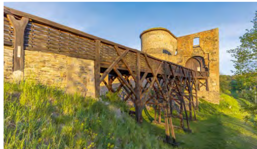
II. 7 Zamek Krakovec, front zamku z zachowaną analitycznie bramą i nowo powstałym drewnianym mostem Fot. Richard Semik / Shutterstock
