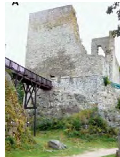
II. 26 Zamek Cornštejn, widok na ścianę szczytową z pałacem na czele zamku. Mur jest spoinowany mieszanką cementową
