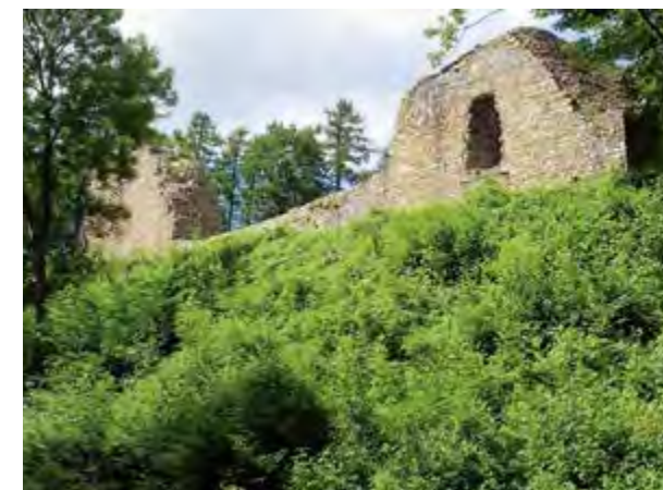
Il. 13 Zamek w Lanckoronie. Widok ściany południowej z pozostałościami obu wież, 2009
