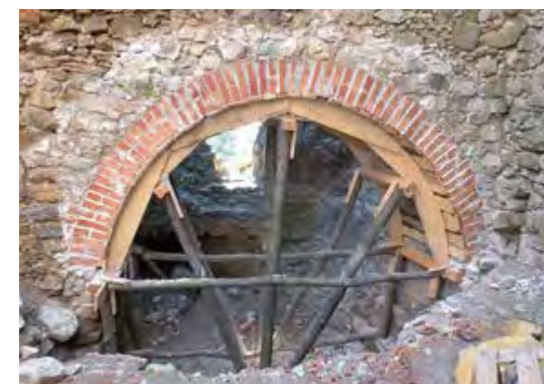
II. 12 i 13 Częściowa rekonstrukcja renesansowego łuku, zamek Jasenov Fot. Peter Glos / Archiwum KPÚ Preszów
