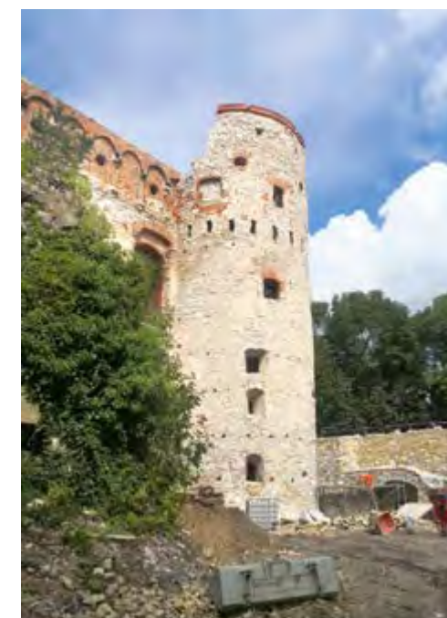
II. 9 Baszta Izabela po pracach konserwatorskich. Na poziomie attyki skrzydła mieszkalnego zachowane ślady ganku na drewnianych wspornikach; dawne wejście na ganek zamurowane. W głębi fragment kurtyny wschodniej podczas prac zabezpieczających, zamek Tenczyn, 2023 Fot. Jan Janczykowski
