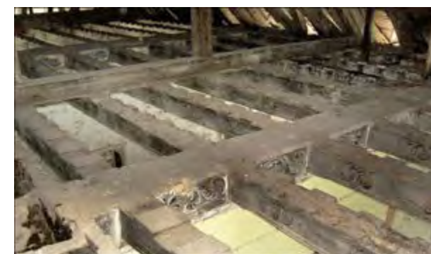
II. 12 Strych pałacu w Sztynorcie podczas prac remontowych
