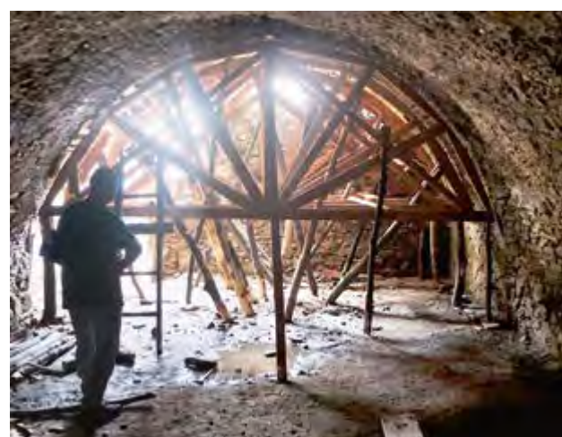
Il. 4 Zadaszenie sklepienia piwnicy na dziedzińcu centralnym, zamek Brekov
