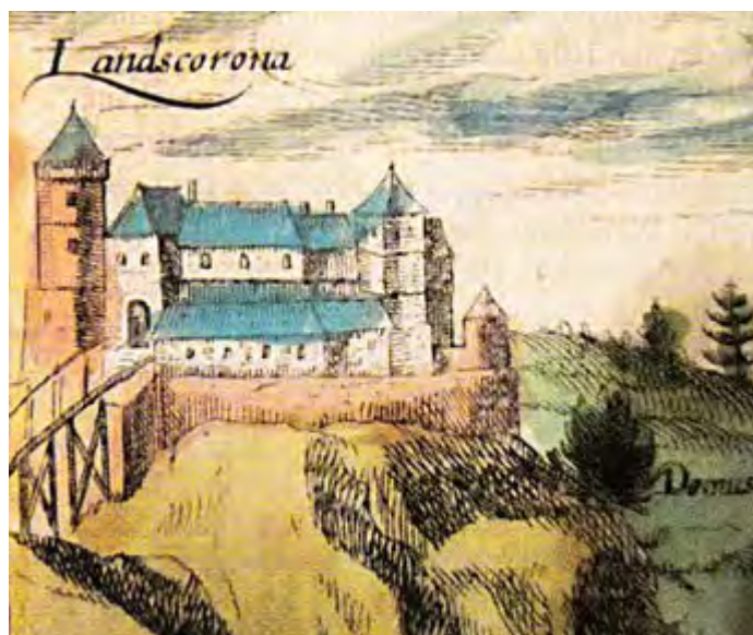
Il. 11 Zamek w Lanckoronie na sztychu Brauna z 1617 r. (fragment większego obrazu obejmującego widok Kalwarii Zebrzydowskiej). Zwraca uwagę wieża przed elewacją boczną i mała, okrągła wieżyczka na rogu umocnień zewnętrznych
