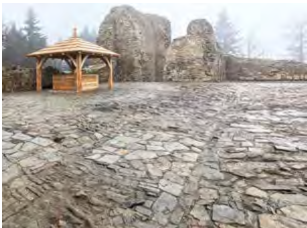
Il. 15 Zamek w Lanckoronie po ostatnich pracach zabezpieczających. Widok na dziedziniec z wieżą południowo-zachodnią w głębi. Zwraca uwagę kamienna nawierzchnia dziedzińca, w znaczącej części autentyczna, odsłonięta podczas badań. W głębi atrapa obudowy zniszczonej studni, 2023
