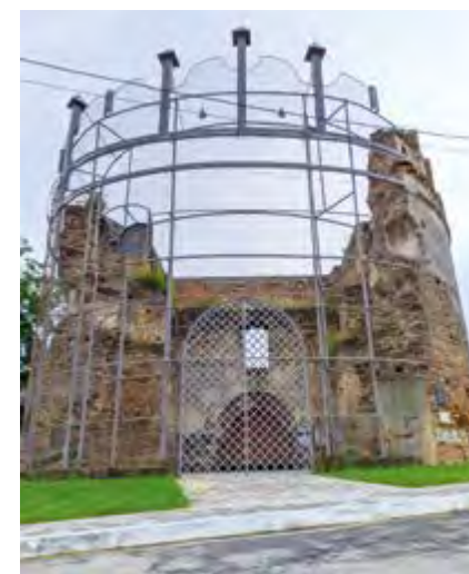
Il. 12 Wieża Tatarska w Ostrogu z odtworzonym z metalu brakującym fragmentem, 2020
