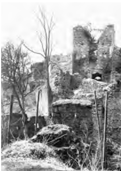
II. 24 Zamek Lukov, wieża wejściowa przed remontem, lata 40. XX w.
