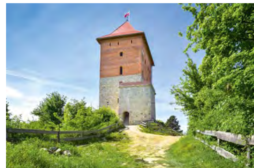
Il. 23 Widoki obecnej formy donżonu zamku w Melsztynie. Pozostałości murów przybudówki w formie wielkiej przypory (nieznanej przez Łuszczkiewicza), odkrytej podczas badań, zostały nadbudowane najpewniej bez podstaw naukowych. Proponowane jej zwieńczenie pseudorenesansową attyką, widoczne na niektórych wariantach wizualizacji projektu, raczej nie jest wystarczająco udokumentowane
