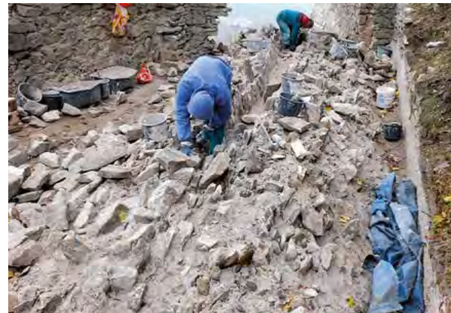
Il. 16 Zadaszenie sklepienia piwnicy, zamek Kapušany Fot. Peter Glos / Archiwum KPÚ Preszów
