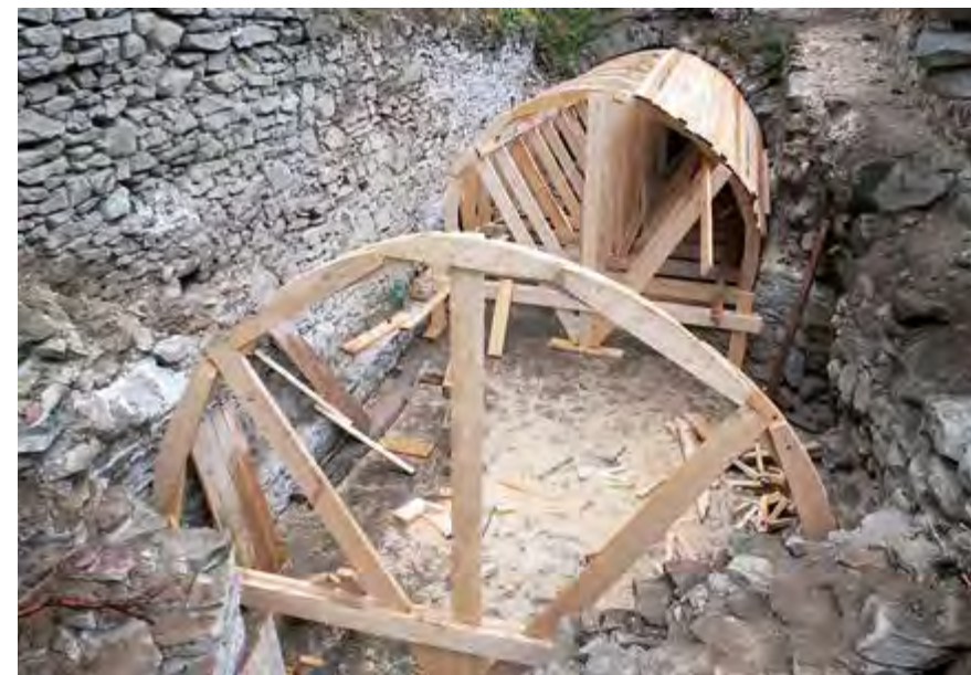
Il. 15 Przygotowanie szalunków do sklepienia piwnicy na dziedzińcu centralnym, zamek Kapušany Fot. Peter Glos / Archiwum KPÚ Preszów
