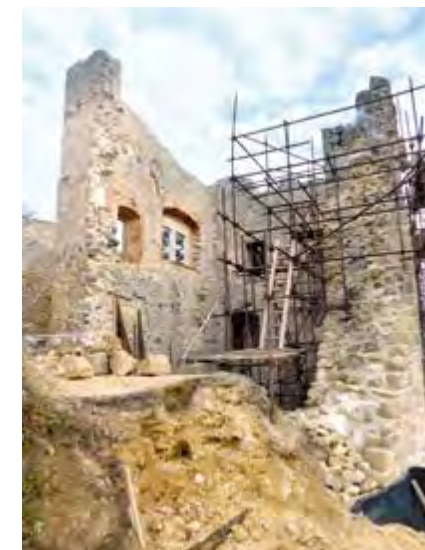
Il. 33 Zamek Cimburk koło Koryčan po dobudowaniu zniszczonej części muru z renesansowym oknem, 2016
