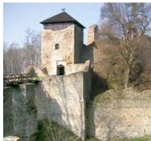
II. 25 Zamek Lukov, obecny wygląd po remoncie i zadaszeniu wieży wejściowej, 2008
