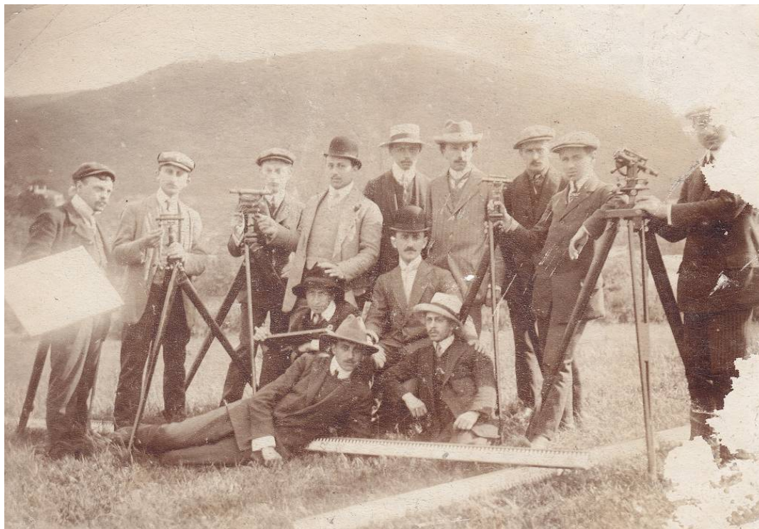
Ekipa mierniczych wytyczająca teren pod budowę schroniska WKN (w oddali grzbiet Maksymca). Fot. nieznanego autora, zapewne z lat 1936-37 (ze zbioru J. Skłodowskiego)
