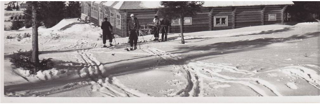
Schronisko WKN – elewacje południowo-zachodnia i południowo-wschodnia. Poczтівka fotograficzna, autor nieznanym, wydanie z lat 1938-39 (ze zbioru J. Skłodowskiego)
